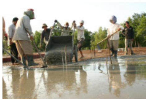
Storten vloer boven, September 2007
