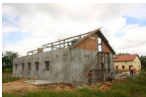
Constructie dak, November 2007
