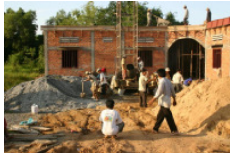
Muren begane grond, juli 2007
