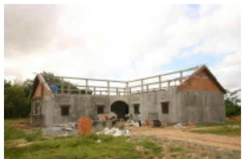
Constructie dak, November 2007
