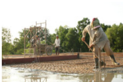
Storten vloer boven, September 2007
