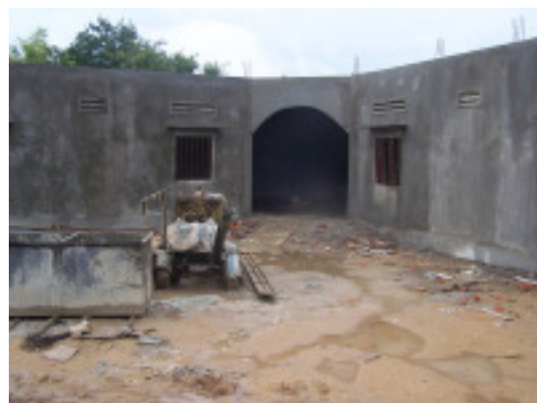
Buiten stucadorwerk, Oktober 2007
