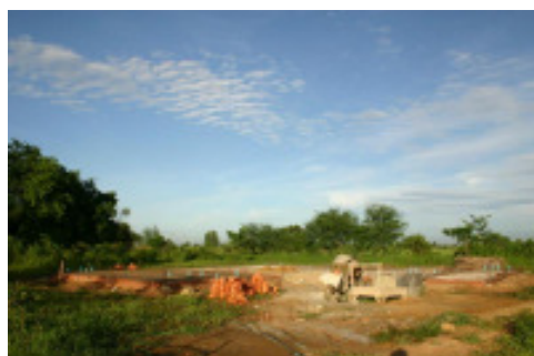
Grondwerk en fundering, mei 2007
