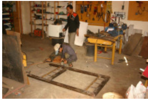
Lassen van de bedden in Kamworks werkplaats, juni 2007
