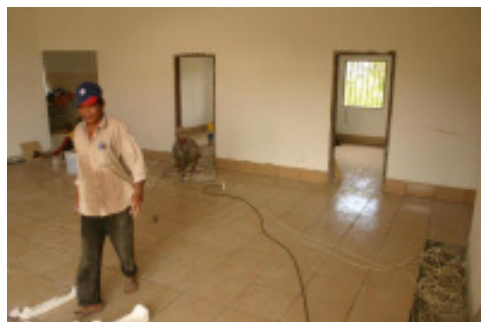
Constructie binnen, November 2007
