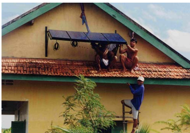
Het installeren van zonnepanelen voor een koelkast voor medicijnen bij een voorgaand project.
