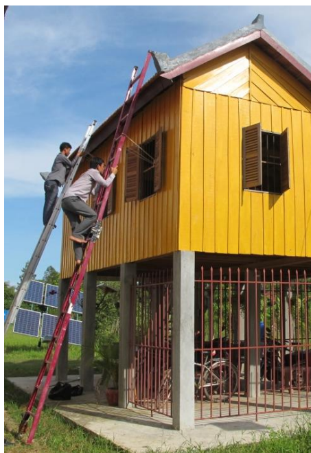
▲ Trainingshuis wordt goed gebruikt tijdens de installertrainingen.
