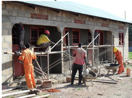
▲ De constructie van het ESCo gebouw bij Kumi Hospital vordert gestaag.
