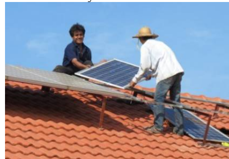
▲ Installatiewerkzaamheden op de Solar Campus. Deze technici zijn in dienst van Kamworks en zijn op de Solar Campus opgeleid, en verdienen hun brood met het installeren van zonnepanelen.
