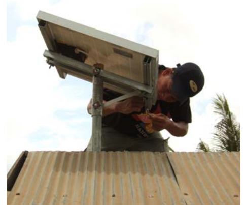
▲ Kamworks installateur bevestigt een zonnepaneel op een Cambodjaans huis
