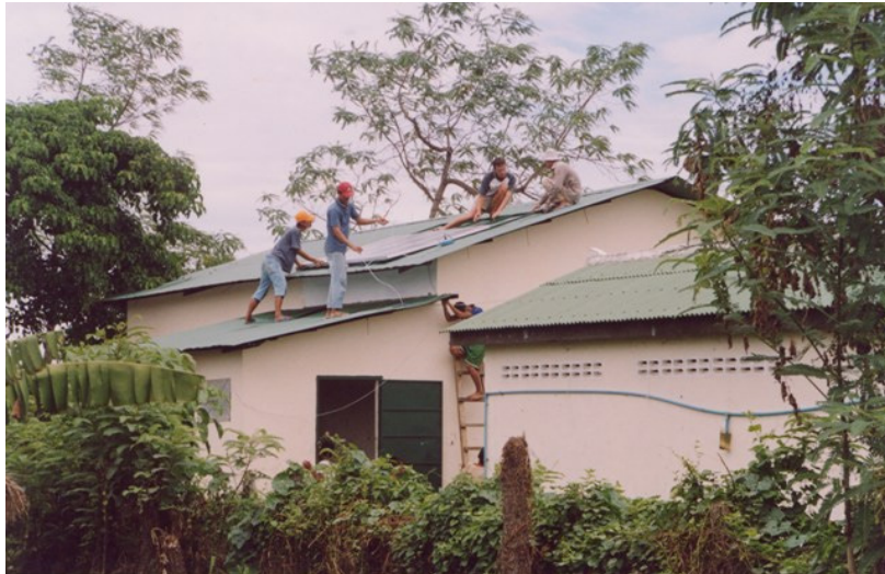
▲ Installatie van zonnepanelen op weeshuis in Cambodja
