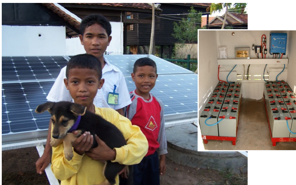
▲ Zonnestroom systeem voor weeshuis in Cambodja. Circa 70 kinderen krijgen voldoende stroom voor verlichting door dit systeem. Ook is er een televisie op aangesloten, voor een wekelijk uurtje vertier. Inzet: De binnenzijde van de technische ruimte biedt ruimte voor accu's, regelaar en omvormer.
