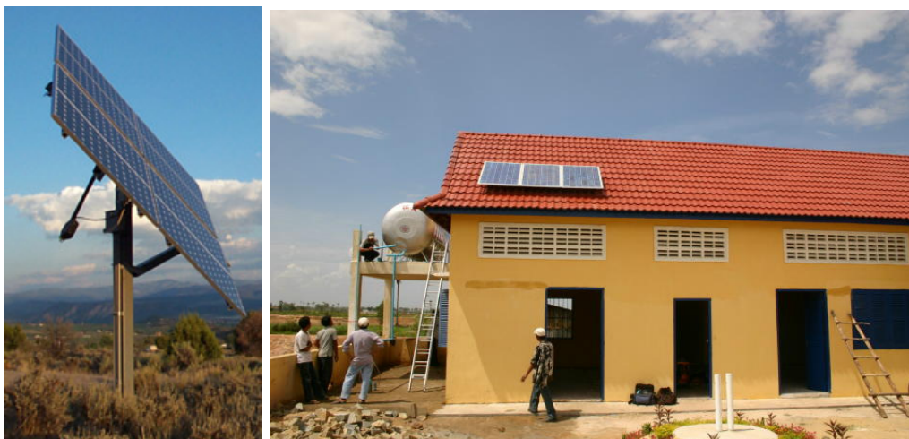
▲ Links: Zonnepanelen op een tracker-systeem kan zorgen tot 40% hogere water opbrengst. Rechts: een statisch opgesteld zonnepanelen systeem
